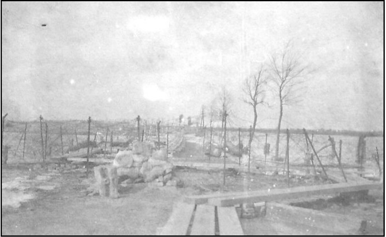
De passerellen richting Schildersbrug op de baan van Pervijze naar Schoorbakke
